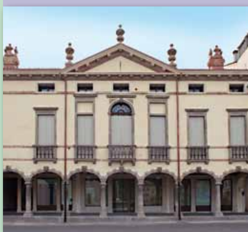
Sopra: la facciata di Palazzo Valeri, Montagnana
